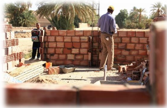
Construction d'un nouveau bâtiment, province d'Errachidia, Maroc
